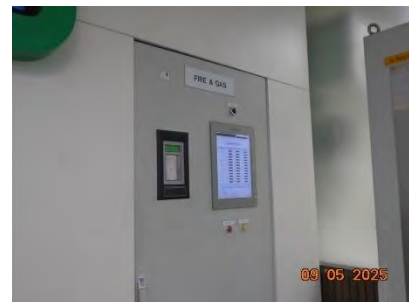
ภาพที่ 2-37 Fire Alarm และแผงควบคุมระบบ Fire Alarm
