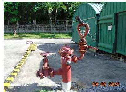
ภาพที่ 2-39 ระบบหัวฉีดดับเพลิงแบบ 2 ทาง
