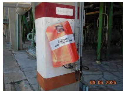
ภาพที่ 2-43 ถังดับเพลิงมือถือชนิดผงเคมีแห้ง
