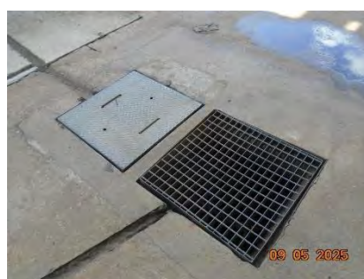
ภาพที่ 2-23 บ่อพักน้ำ (Sump)
