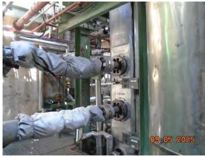
ภาพที่ 2-34 Rupture Disc PSF บริเวณ Vent Stack
