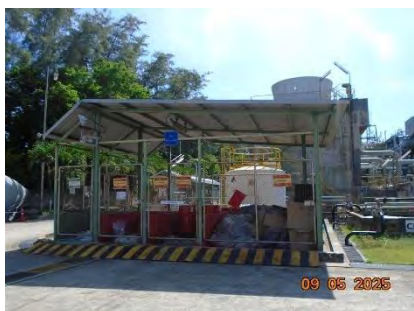
ภาพที่ 2-10 พื้นที่รวบรวมน้ำมันและไขจาก API Separator
