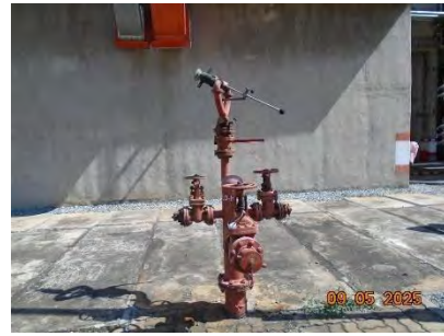
ภาพที่ 2-35 Three-Way Valve (Fixed Monitor)
