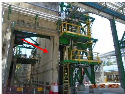
ภาพที่ 2-32 กำแพงกันระเบิด (Blast Proof Wall)
