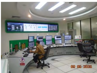
ภาพที่ 2-3 การตรวจสอบ และควบคุมการทำงานผ่าน DCS ที่ CCR
